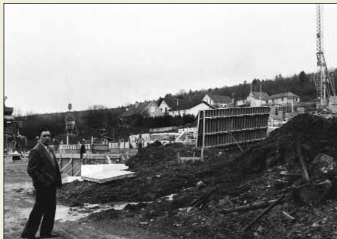
Jacques Garcia devant les travaux de rénovation du quartier des Fays en 1984
