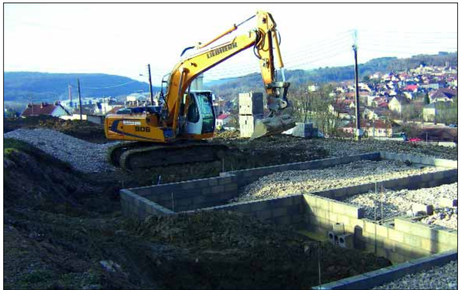
Les premiers travaux du nouveau lotissement de Fays
